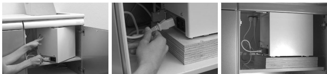
**⚠️** Gerät einbetriebnahme nur in eingebauter Endposition. Bei Wartungen und Demontage der Einbausituation muss das Gerät vorgängig zwingend vom Hausnetz (100-230V) getrennt werden!
